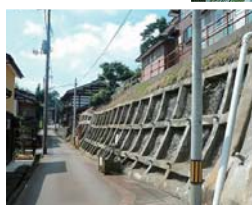
急斜面下の道路は 頑丈に補強
