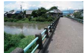
現在の新塩田橋
